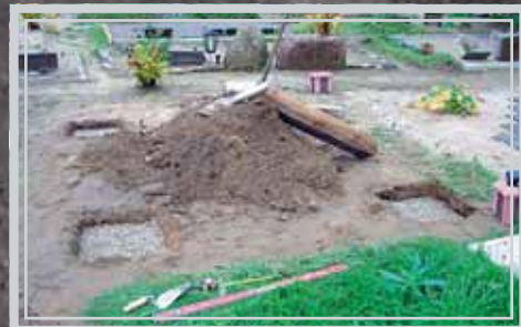
Hauapiirete paigaldus alusele. Установка оград на основаниях. Tombfence installation on the bases.
